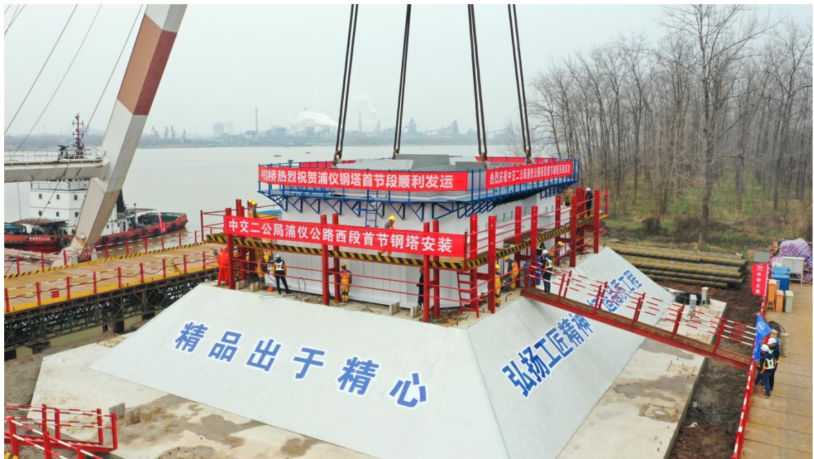
钢塔首节段安装
