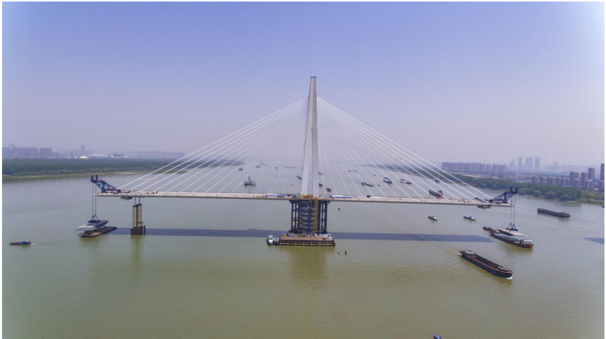
图 6 钢混组合梁吊装
