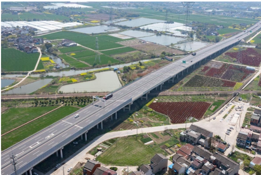
新长铁路特大桥
