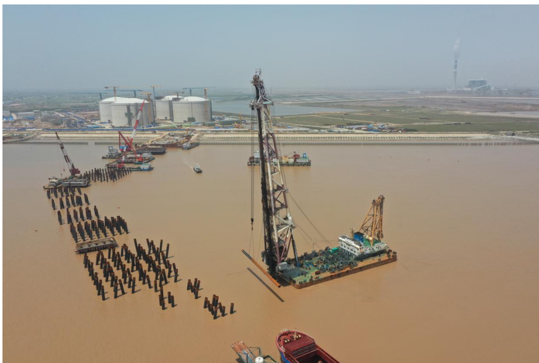
LNG 码头靠船墩 3-15#钢管桩沉桩
