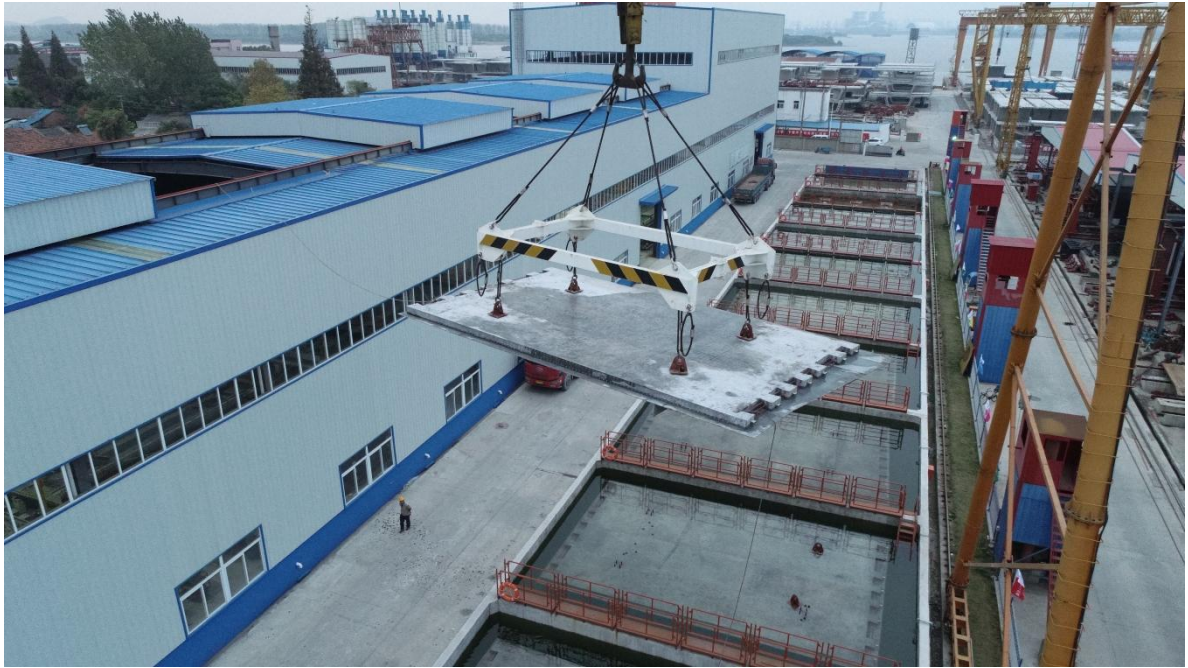
图 5 UHPC 桥面板预制
