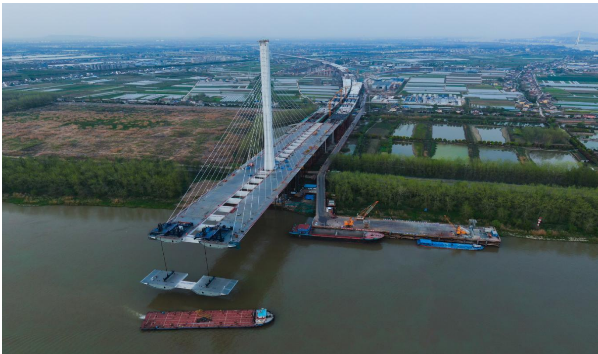
主桥分幅式钢箱梁吊装
