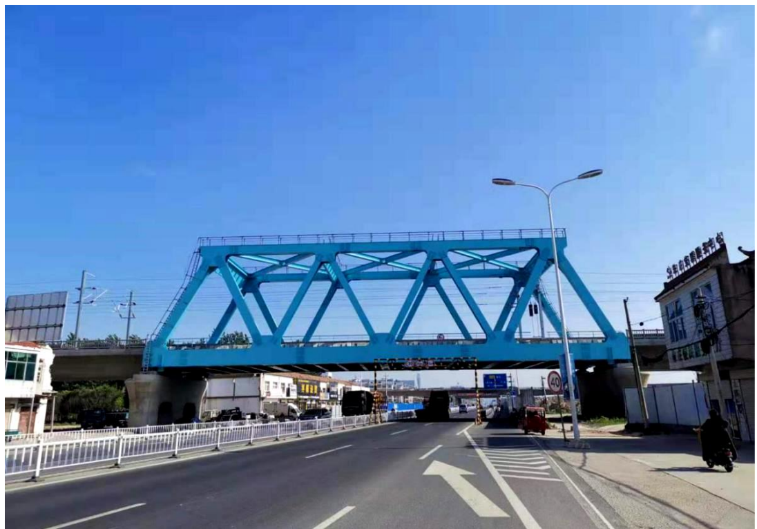
徐洪河特大桥钢桁梁
