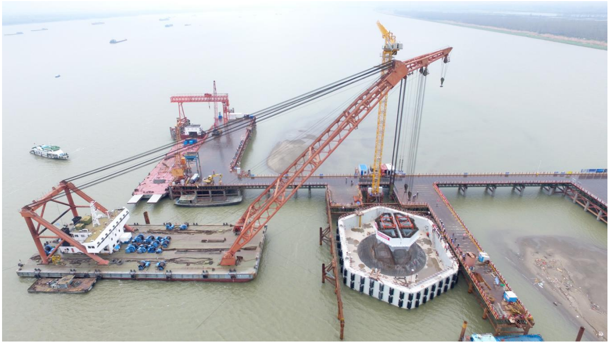
图 3 索塔钢壳吊装
