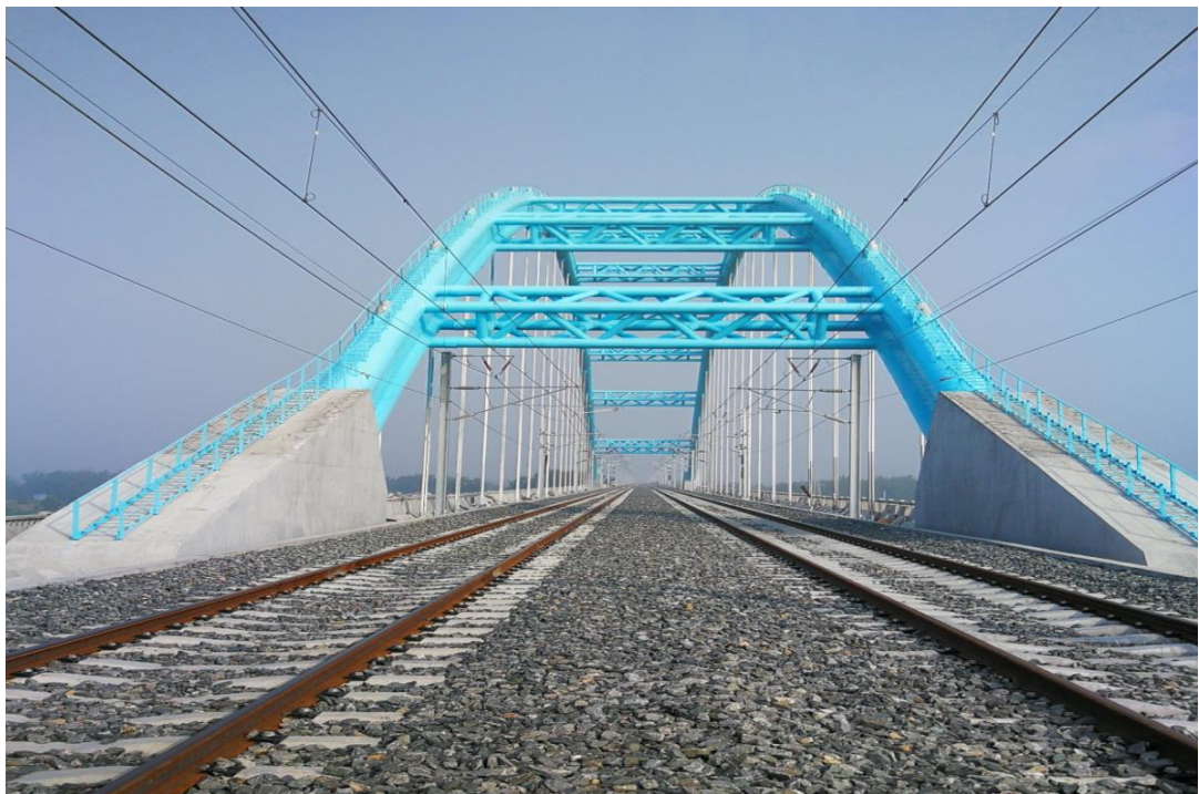
徐洪河特大桥 200 米连续梁拱
