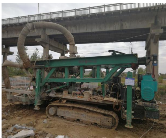
液压反循环钻机施工
