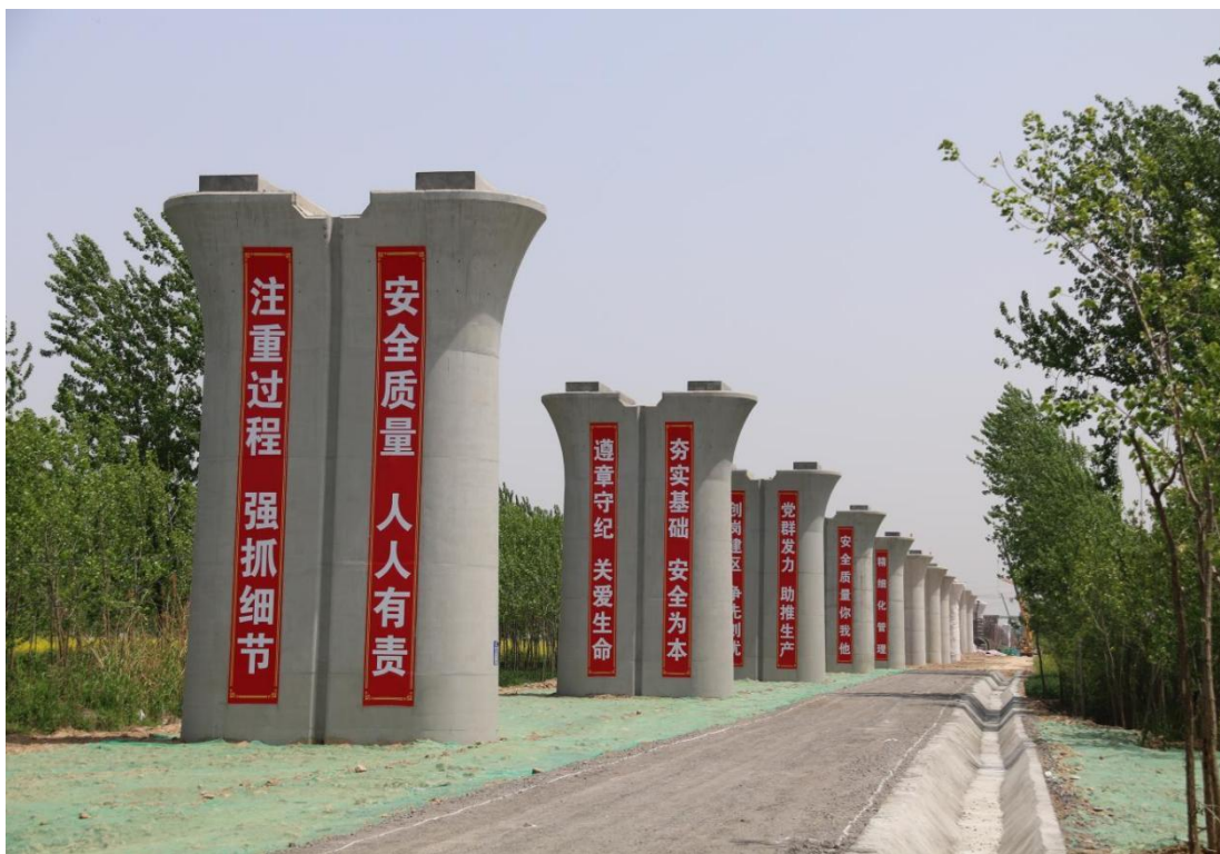
徐洪河特大桥墩身
