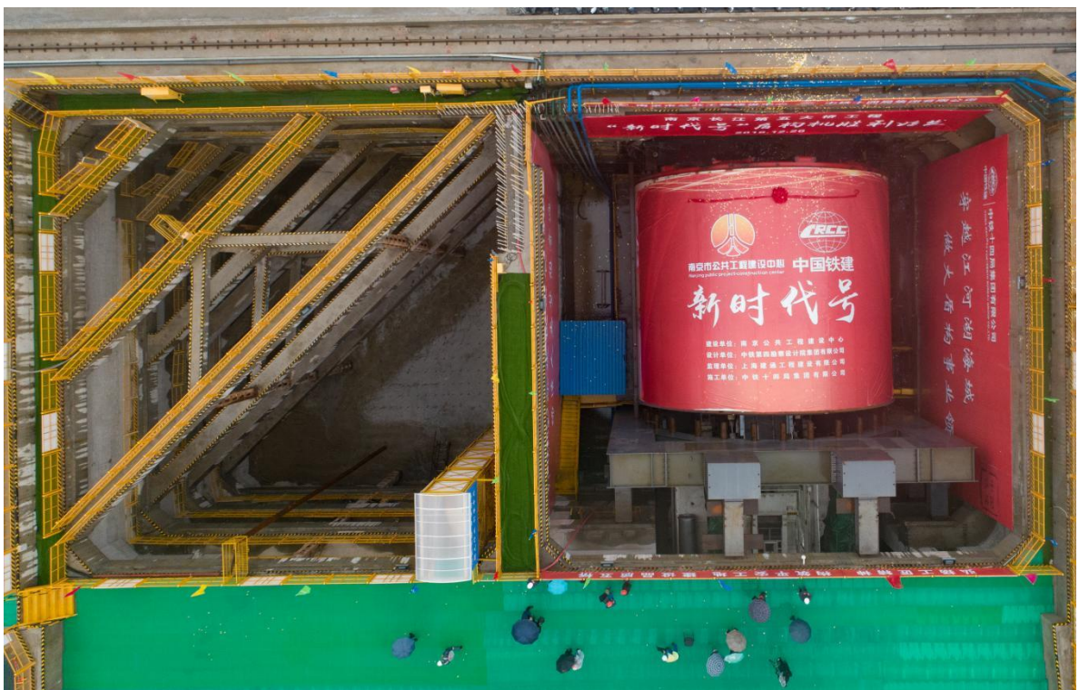
图 8 夹江隧道盾构始发
