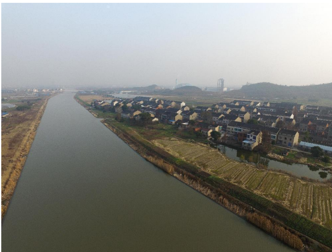
整治后的航道
