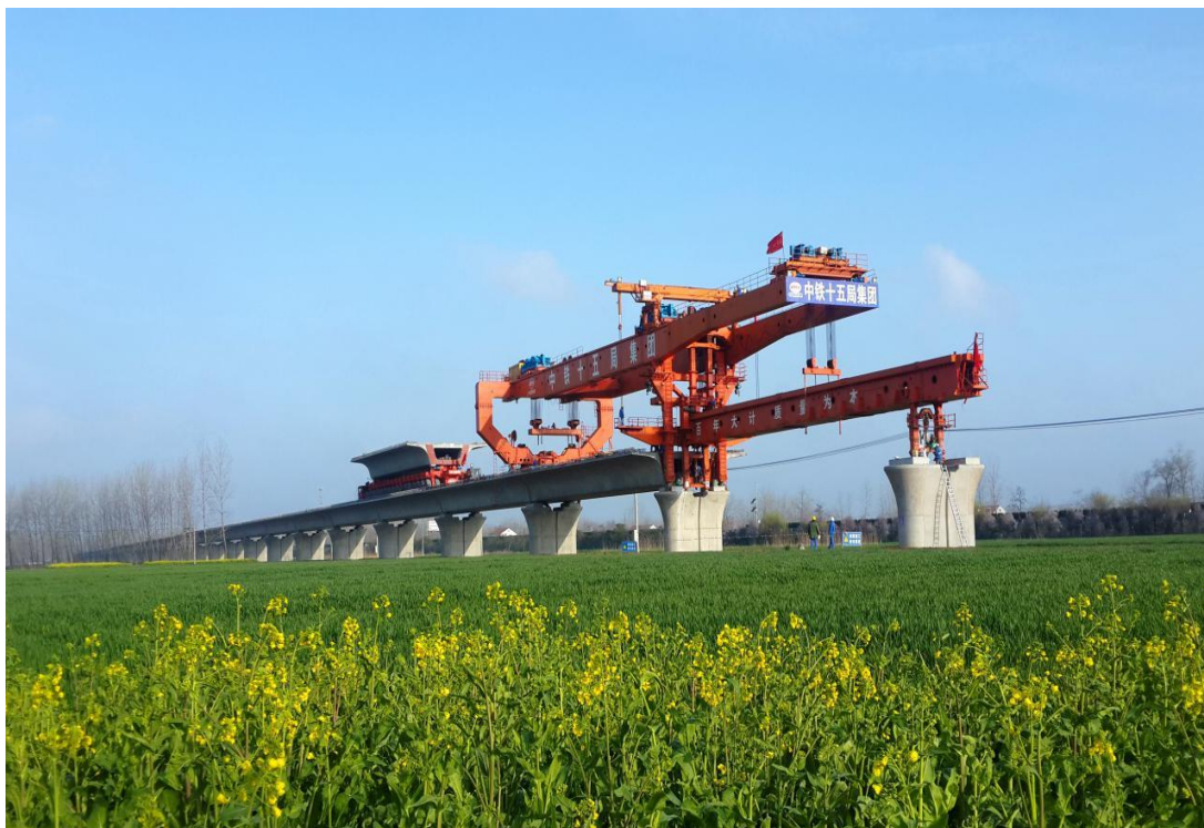
徐洪河特大桥架梁
