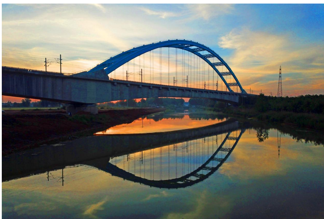
徐洪河特大桥200米连续梁拱
