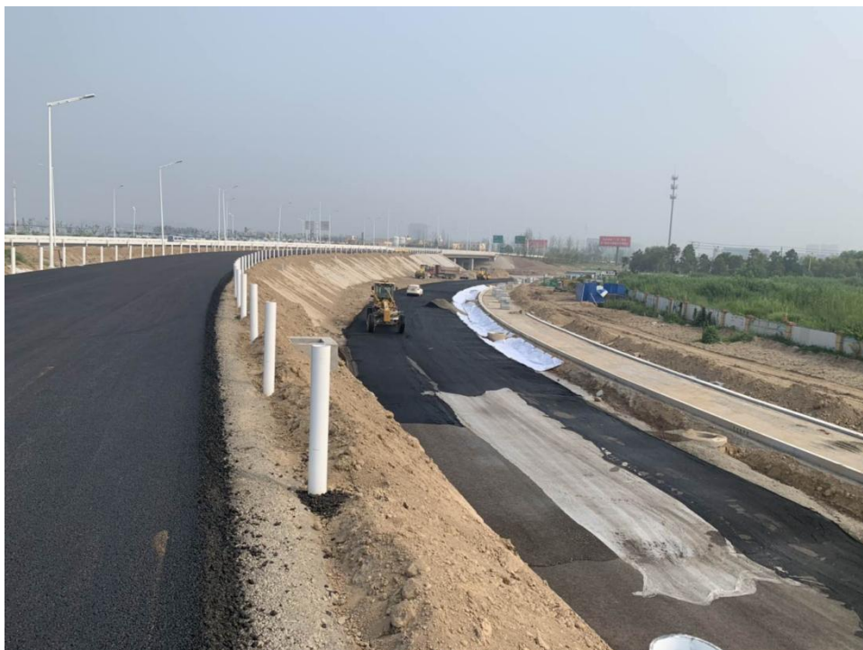
互通水稳、沥青施工图片
