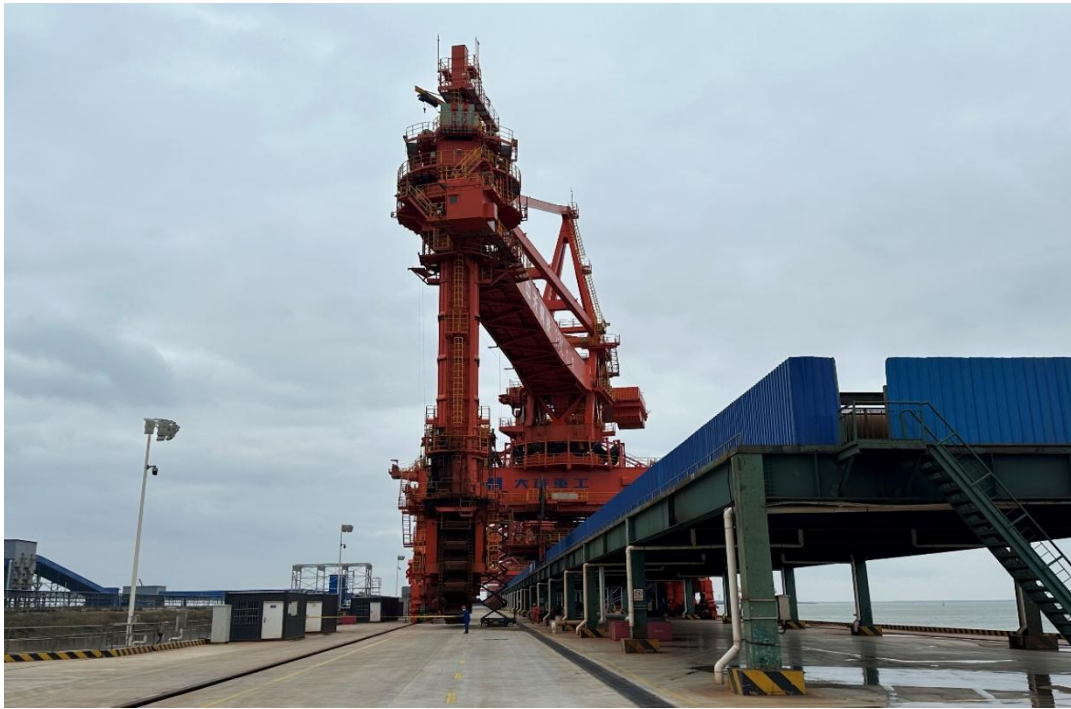
钢结构廊道及链斗式卸船机
