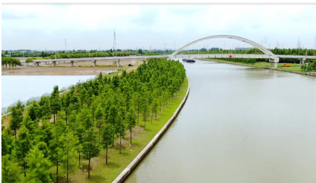
杨林塘航道太仓段主航道及桥梁
