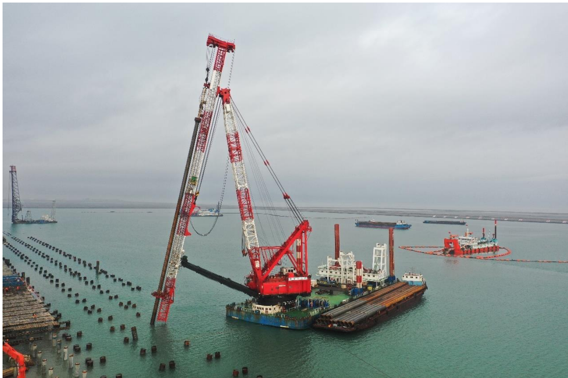
宁波海力 801 打桩船水上沉桩
