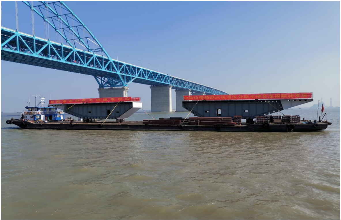
主桥分幅式钢箱梁运输
