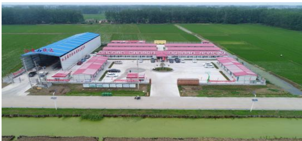
项目部办公、生活区及钢筋加工场
