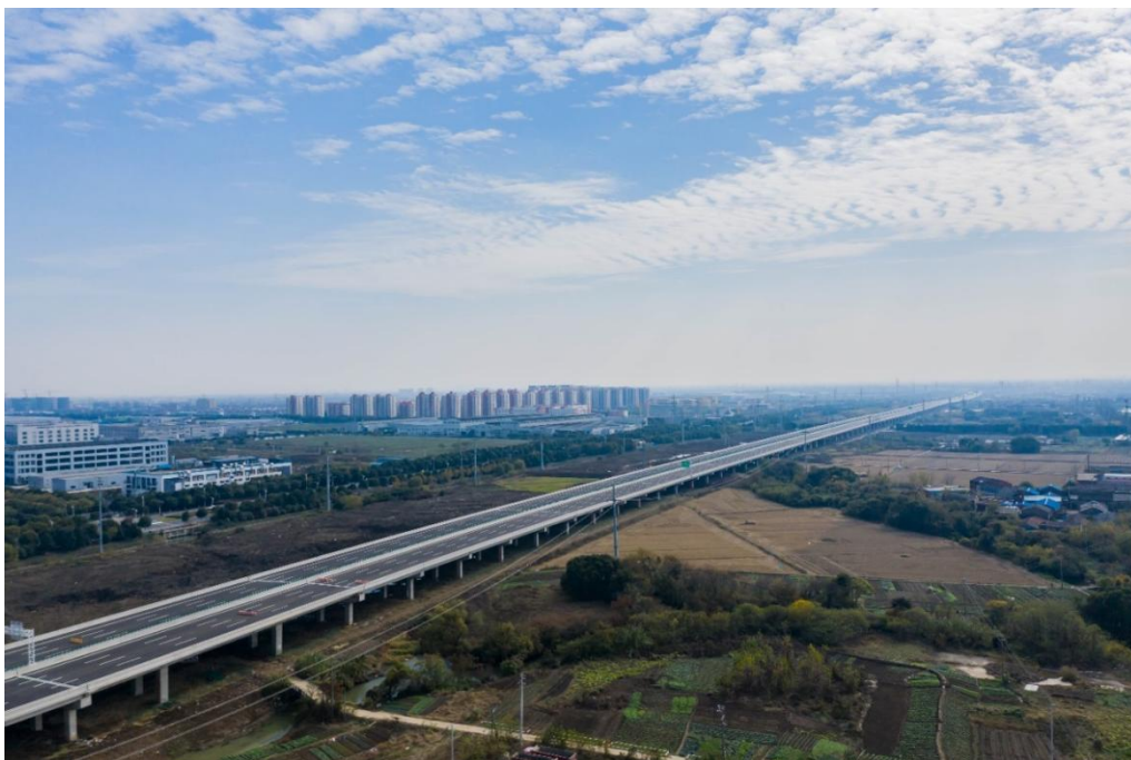
武进高新区高架桥
