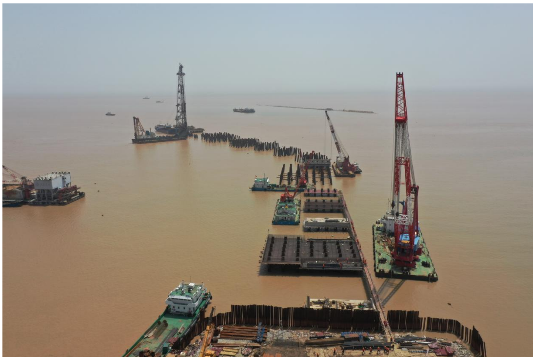
LNG 码头靠船墩 3-15#钢管桩沉桩
