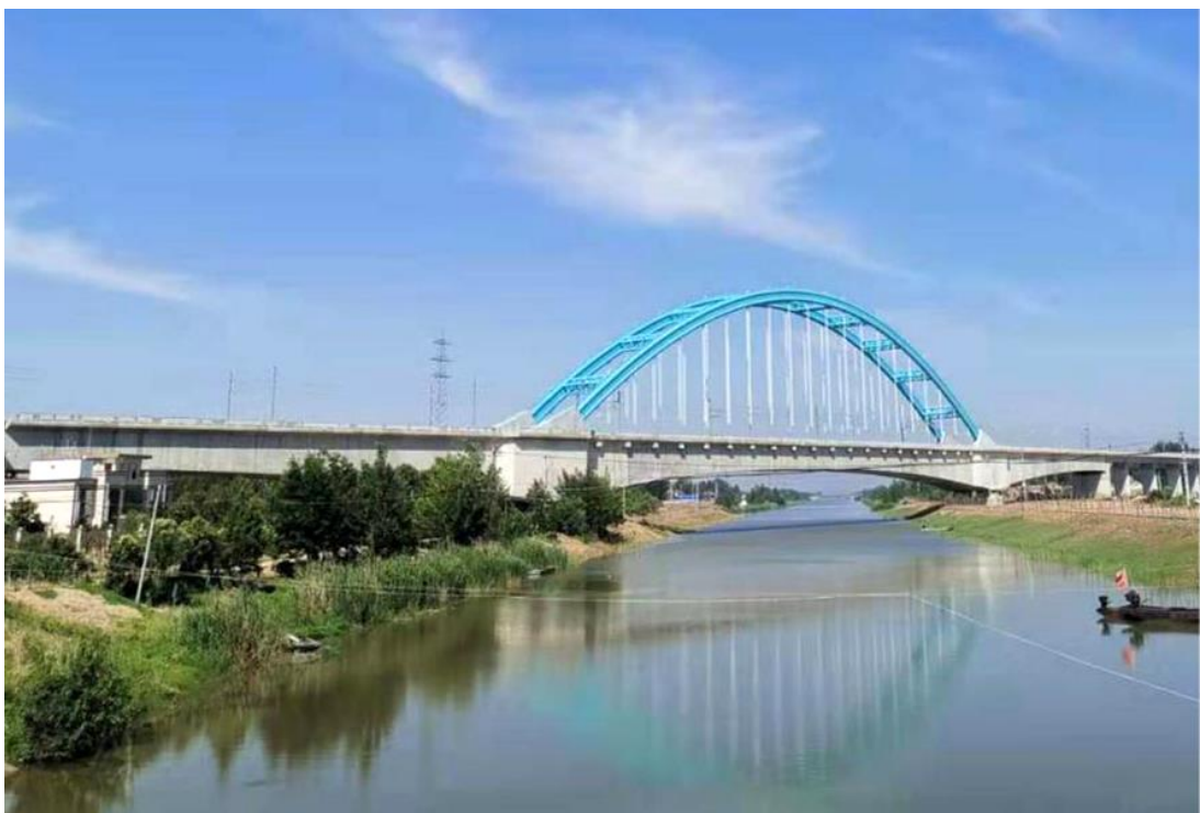
徐洪河特大桥 200 米连续梁拱
