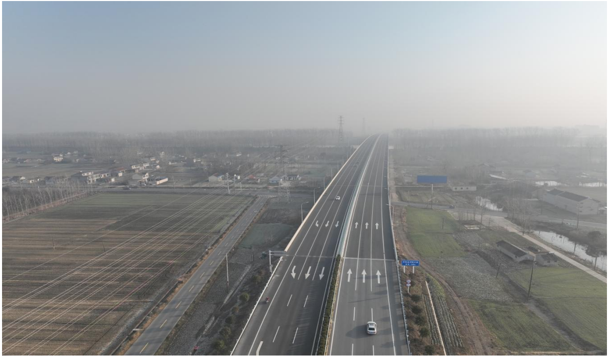
京杭运河特大桥
