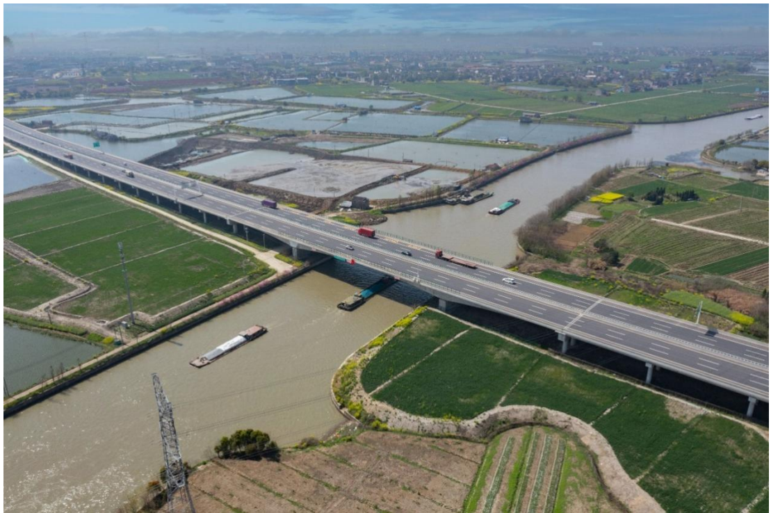
锡溧漕河特大桥
