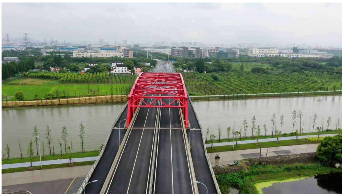
昆山段航道上桥梁
