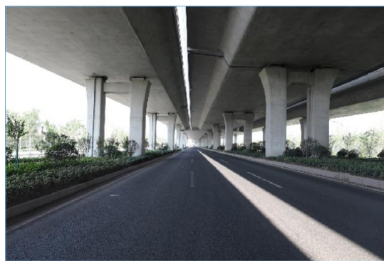
(3) 桥梁上部结构外观
