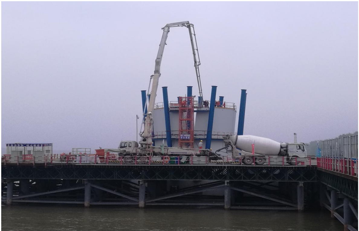
图 4 索塔混凝土浇筑
