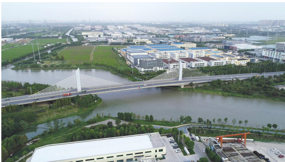
金鸡河吴塘河段上桥梁
