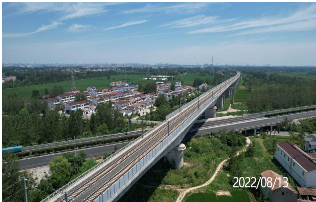
徐洪河特大桥跨高速公路连续梁
