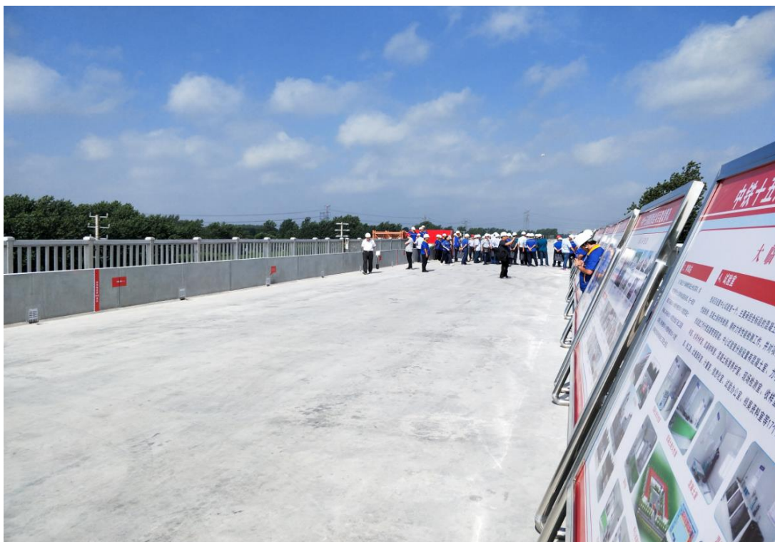
徐洪河特大桥桥面系观摩
