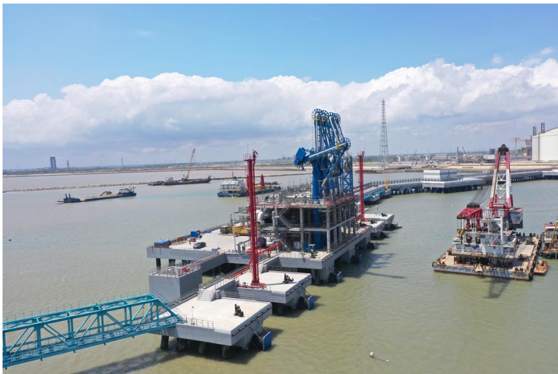
LNG 码头箱梁安装
