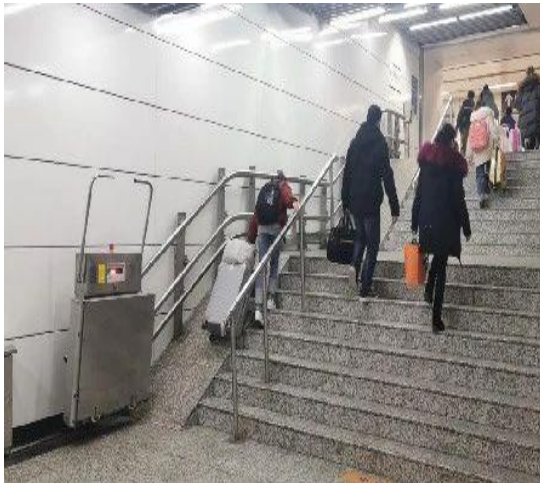
坡道改造前乘客艰难换乘
