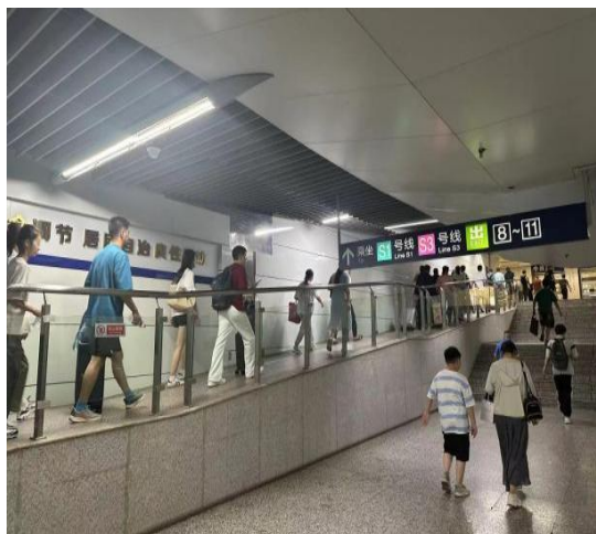
坡道改造后乘客轻松换乘
